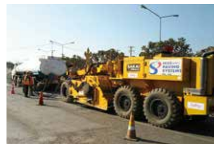
カンボジアでのスタビライザー施工状況
