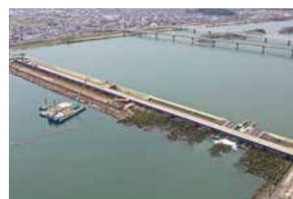
高梁川鶴新田河道整備外工事
