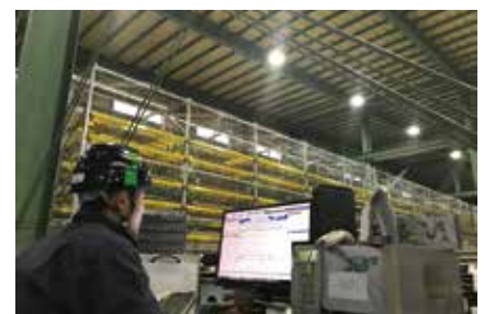
小ロット、多品種に対応した自動倉庫
