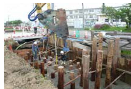
丸太杭を用いた地中の森工法
