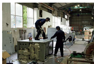
作業現場でのインドネシア研修生
