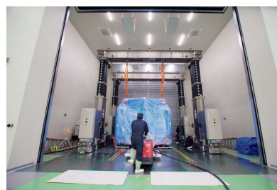
精密機器用クリーンルームを6室完備
