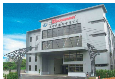
2013年に稼働した新台湾工場
