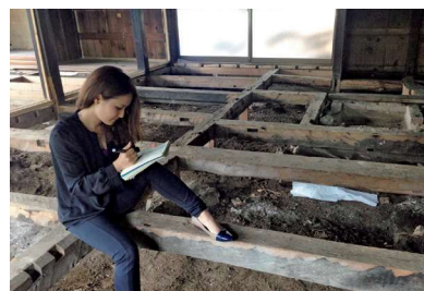
クラウドファンディング活用による改修中の様子
