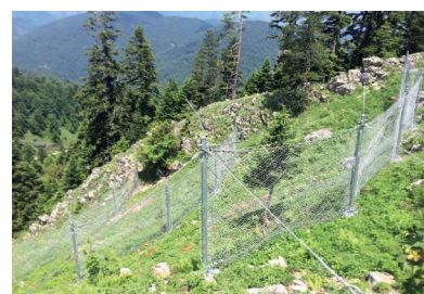
トルコで雪崩対策事業、雪崩予防柵を試験設置
