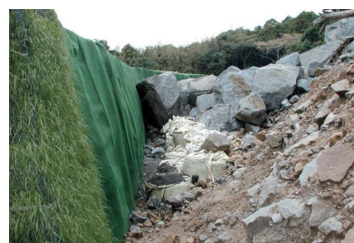
極めて優れた衝撃吸収性能を持つジオロックウォール
