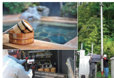
水深630mの温泉ポンプの入替工事
