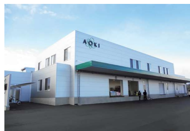
フルーツ冷凍加工の拠点となる本宮工場
