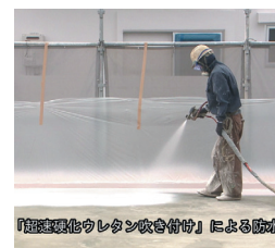
「超速硬化ウレタン吹付」による防水
