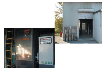
温水ボイラー室
