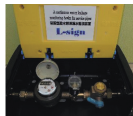
大幅な業務効率化を図ることができる漏水調査機器「L-sign」
