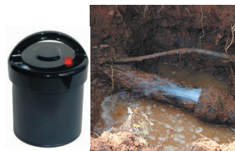
開発製品と発見漏水
