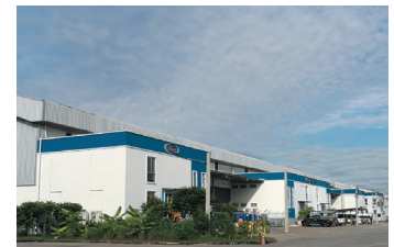
完成時総床面積 1 万坪の最新鋭タイ工場
