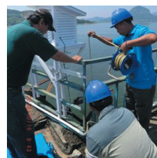
インドネシアのダムに製品を設置
