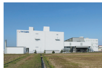
2015年12月新設のP号棟
