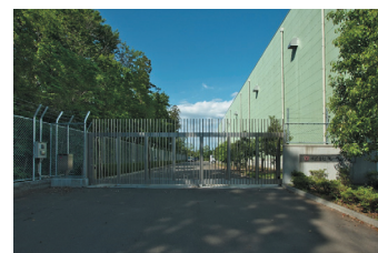
保管施設外観
