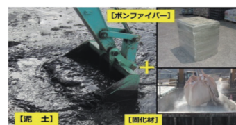
ボンテラン工法
