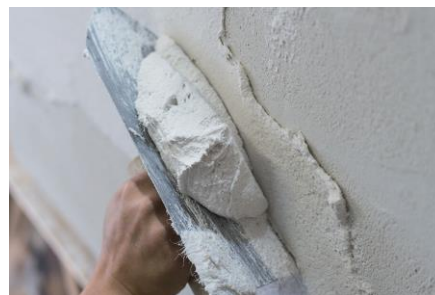
しっくい施工
