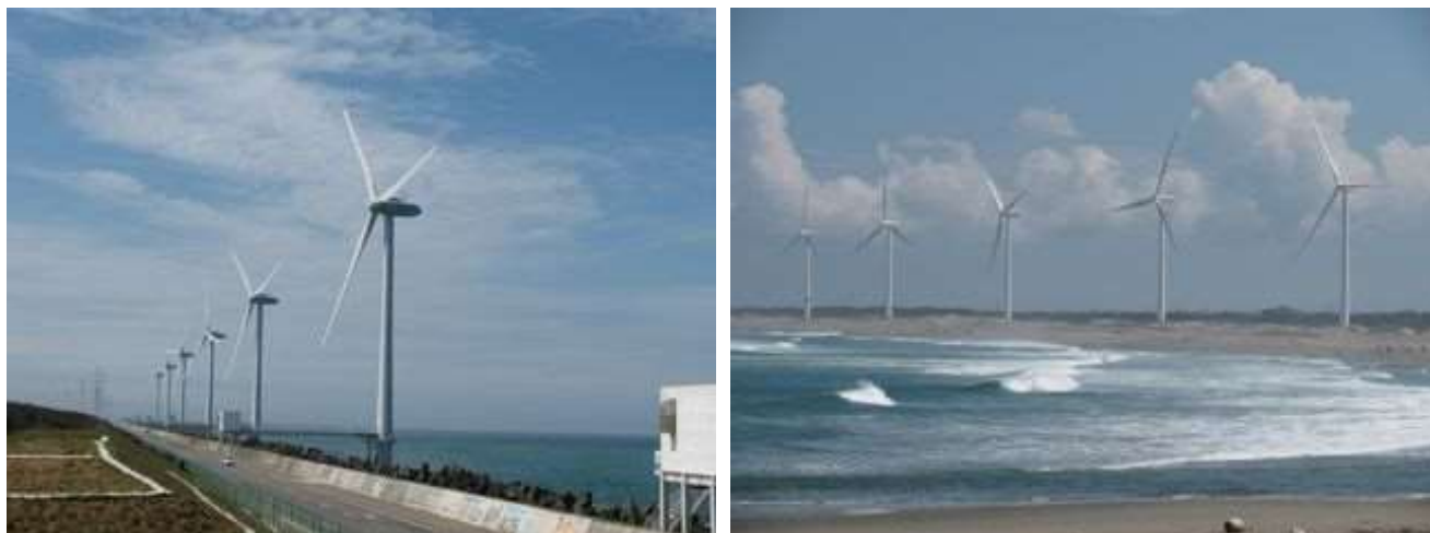
図 1-5 神栖市に設置されている風力発電の一例 （神栖市ホームページより）
