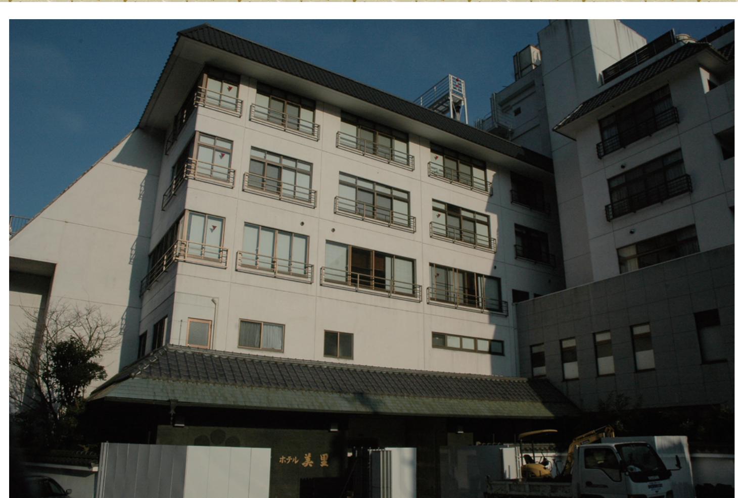
修復工事が進む「ホテル美里」
