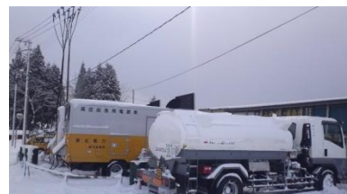
電力復旧作業車への燃料供給
