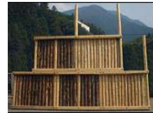
(間伐材を用いた型枠)
