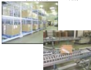
(物流センター内の設備)
