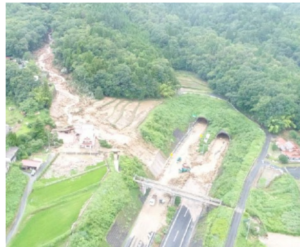
土砂で埋まった高速道路（山陽道）
