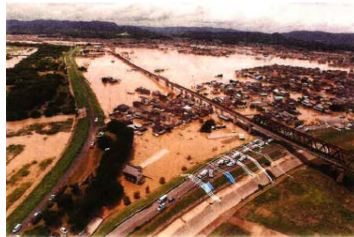
河川の堤防決壊（岡山県倉敷市真備町）
