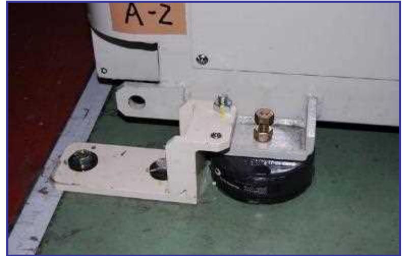
アンカー固定（防震ゴムとの併用）
