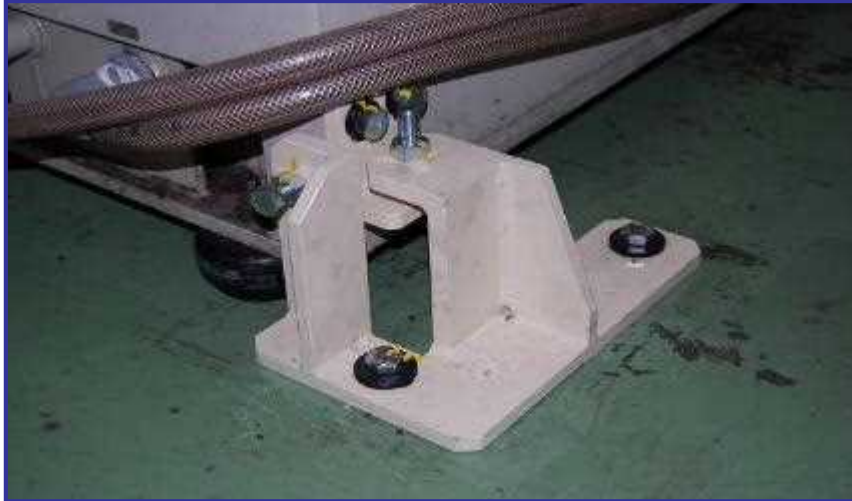
アンカー固定（転倒防止）
