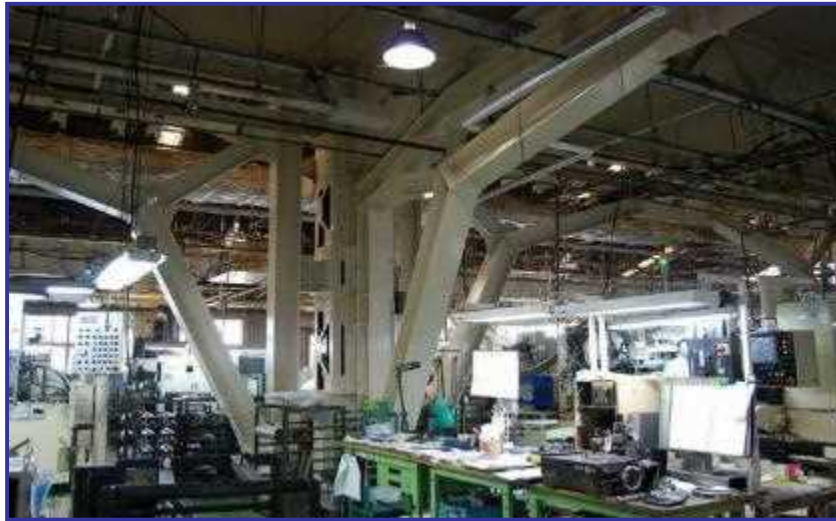
建屋耐震補強 (柱の基礎部)
