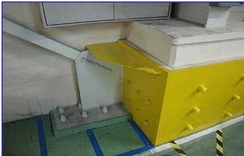
建屋耐震補強 (柱の基礎部)
