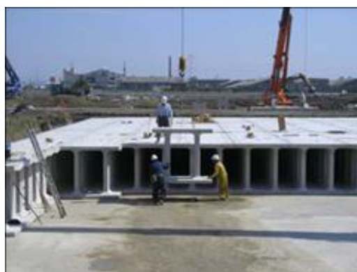
雨水地下貯留槽施工例
