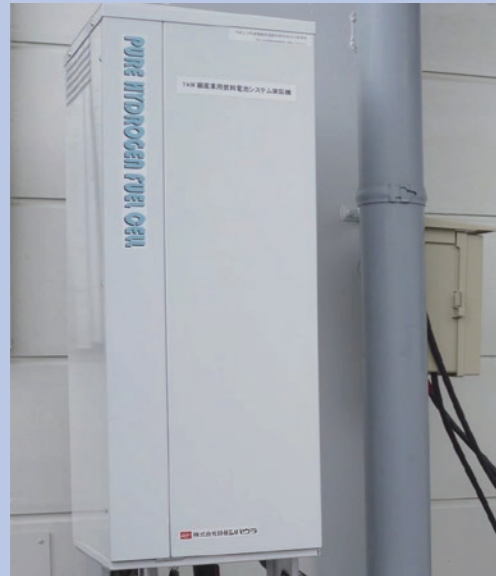
1kW級産業用燃料電池システム実証機
