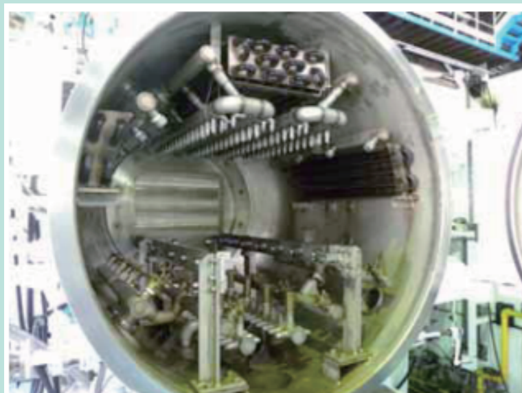
実証炉内部の、ミスト冷却装置設置状況
