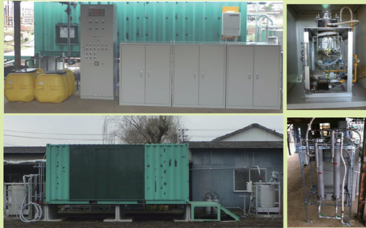
スターリングエンジン発電装置3基(左上)、1kW SE単体(右上) 消化液タンク・メタン発酵槽・レシーバータンク(左下)、脱硫脱臭装置(右下)
