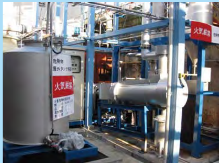
加熱水蒸気油分回収実証試験装置
