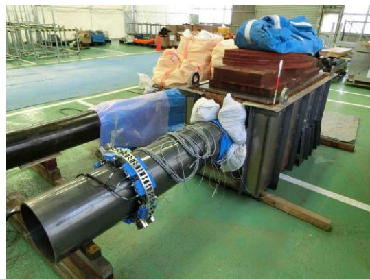
図2.1.1.3 埋設後（重り積載後）の写真
