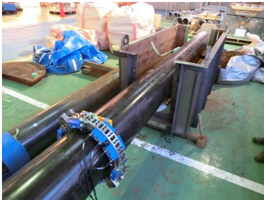
図2.1.1.2 埋設前の写真
