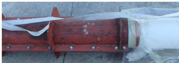
図 更生基材の加熱硬化状況
