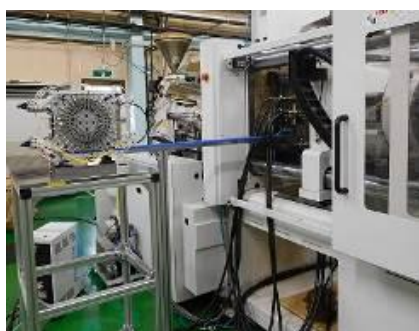
図 36 自動挿入機の設置装置
