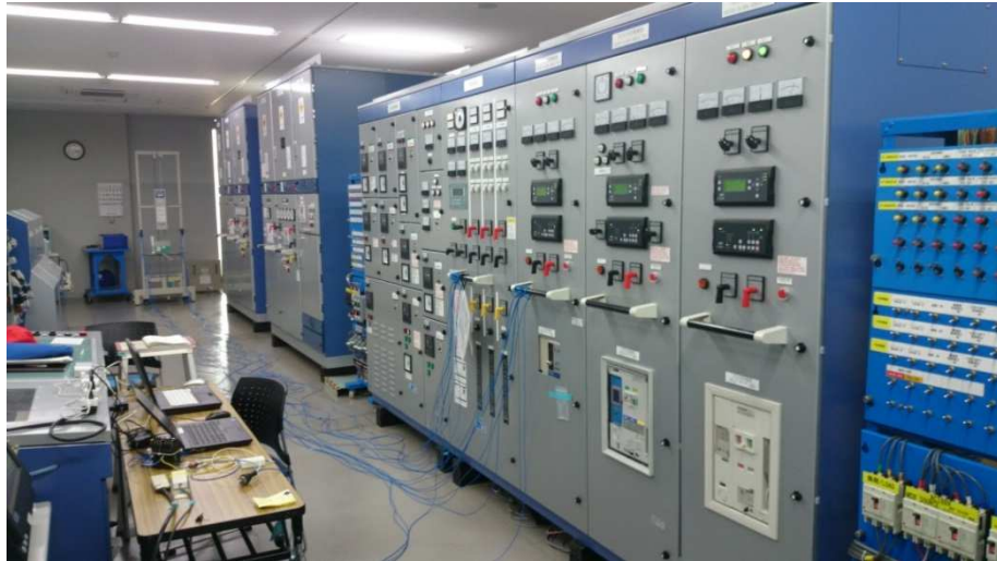
図 2-5-4 実験を行ったシミュレーター室
