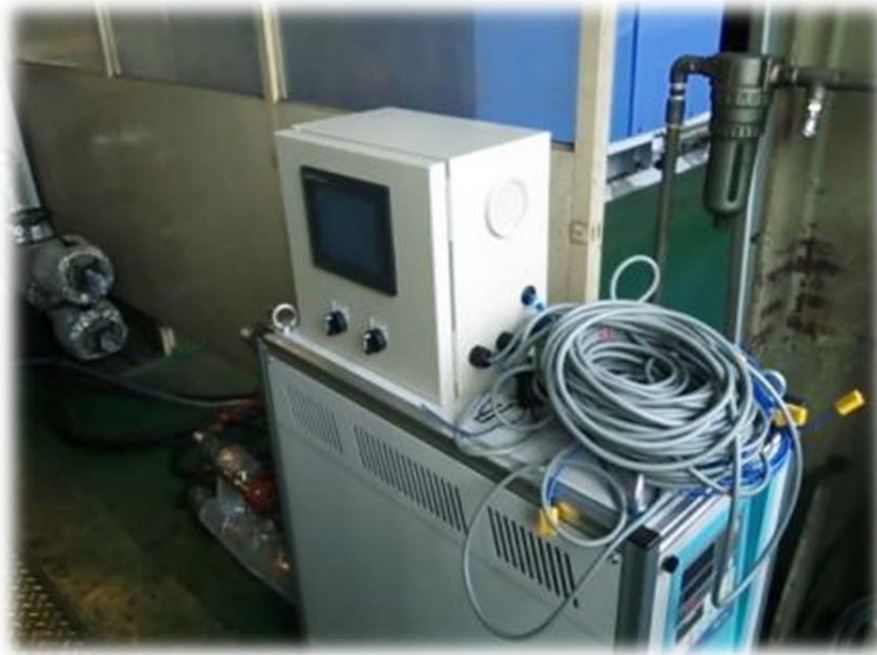
写真 7 温調機並びに制御ユニット
