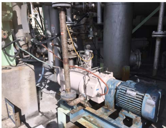
図 2-2-1 川下企業での試験運転の様子
