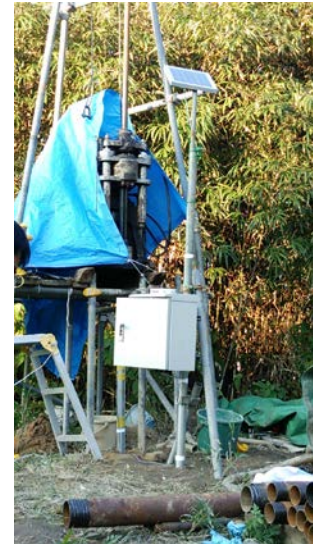
写真 2-2 多機能変位計測システム設置完了状況
