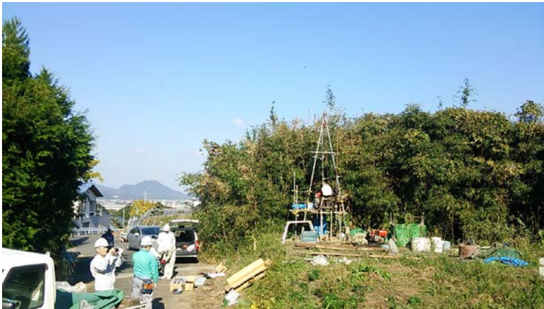
写真 2-1 追加実証実験個所全景
