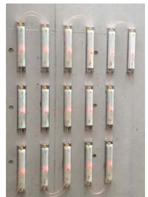
非接触給電・通信インフラコンクリート壁面高精度変位計測
