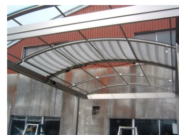
④膜材を設置したキャノピー(1列)
