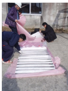
②膜材のフレームへの設置
