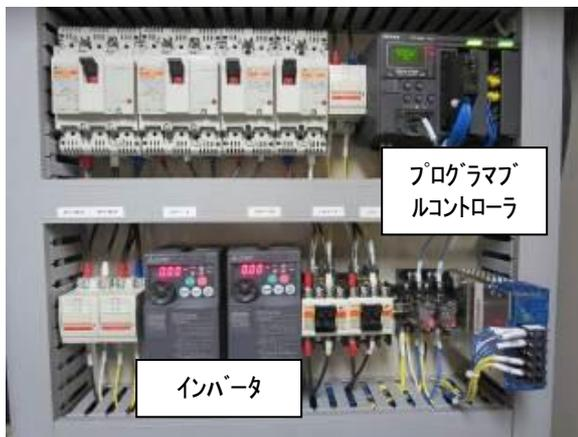
図 2.6-5 PLC(プログラマブルコントローラ)、インバータ
