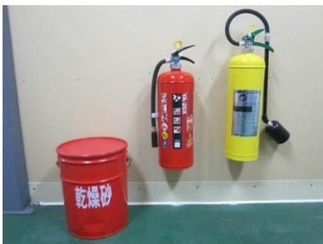
图-2.2.6-1 (左) 乾燥砂保管容器、(中) ABC 粉末消火器、(右) 金属火災用薬剤散布器
