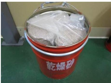
图-2.2.6-2 乾燥砂保管容器
