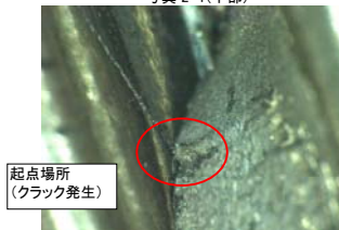
<破損部位拡大>
