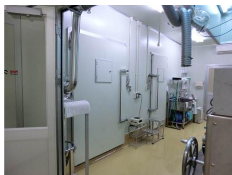
図 7 大型固体発酵装置外観
