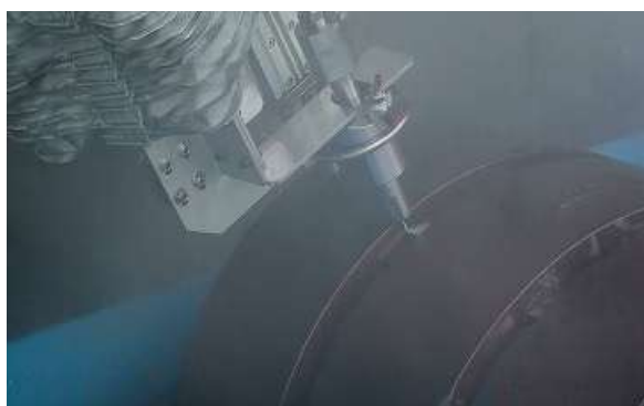
Fig. 32 高圧水吐出, 切断
