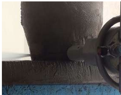
Fig. 35 高圧水吐出, 切断
