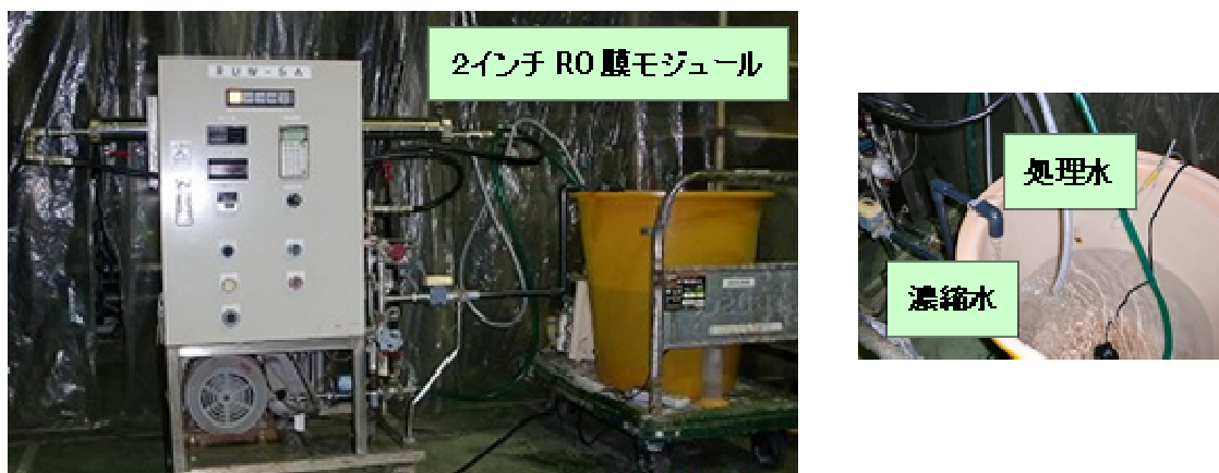
図 19. 低圧 RO 膜パイロットプラント (左)、原水タンク内 (右)
