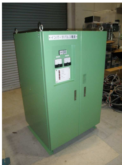
図 3-1 パルス電源・制御回路構成部。
