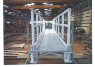
組立て完了状況(横桁除く)
