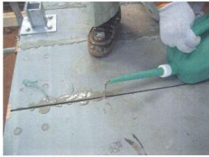
グラウト材注入状況
