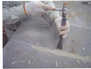
はみ出したグラウト材のはつり
