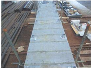
グラウト完了状況(上面)
