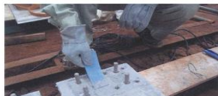
上フランジ塗装はがし、水平プレス取付
