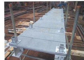
手すり支柱金具取付け
