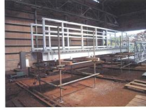
組立て完了状況(横桁除く)
