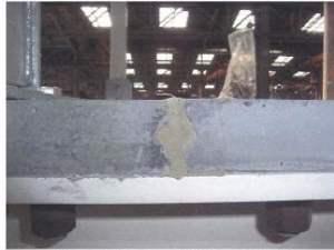
グラウト完了状況(側面)
