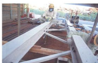
上フランジ塗装はがし、水平プレス取付
