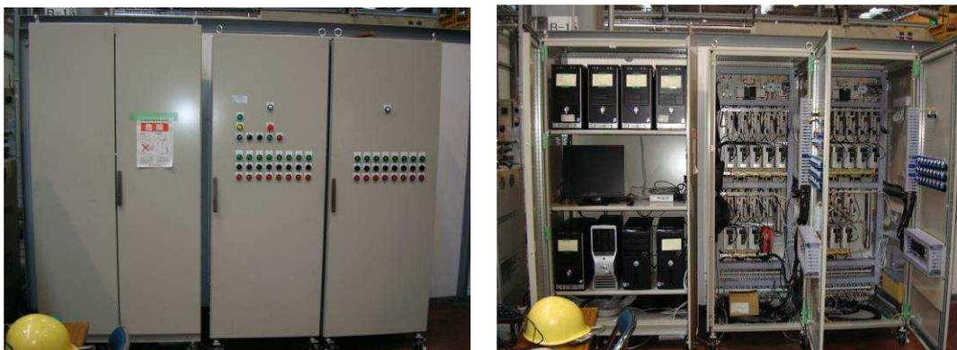
図 2.1.3.2 PC集中ラック&制御盤（操作面、内部）
