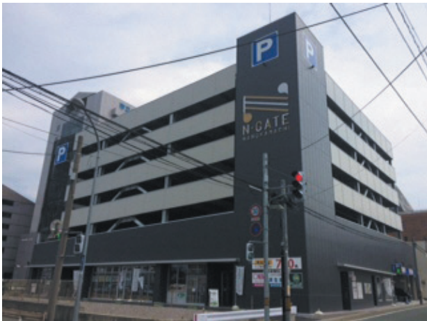
「N-GATE NANOKAMACHI」の外観
