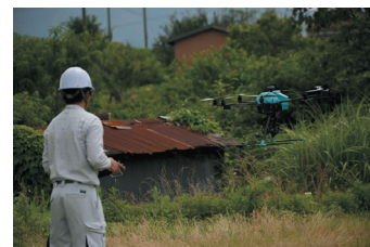
UAV（ドローン）を活用した測量
