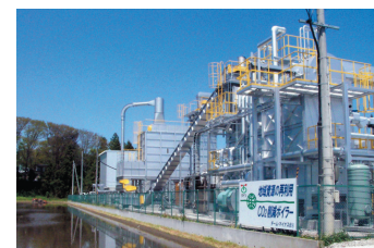
間伐材の活用による木質チップボイラーの導入
