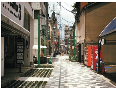
アーケード撤去後の通り
